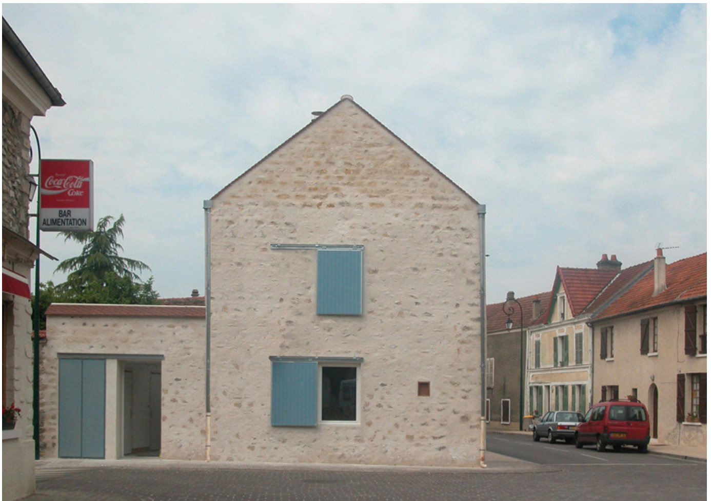
Vue de la façade principale depuis le chemin de la petite ligne.
